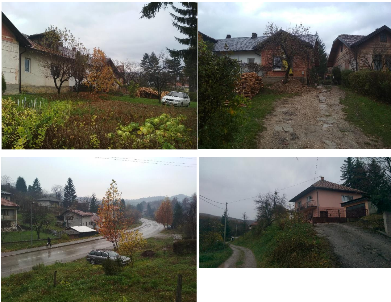
SLIKA 3 – ZATEČENO STANJE IZGRADENIH OBJEKATA (terenski obilazak dana 12.11.2019.)
